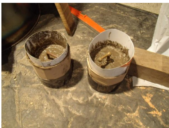
Bouchons (coniques ou non) pour les trappes de ramonage du collecteur. A rendre le plus étanche possible au moyen de joint minéral.
