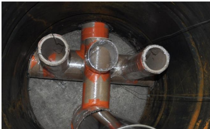
Le collecteur connecté des 2 cotés aux trappes de ramonage
